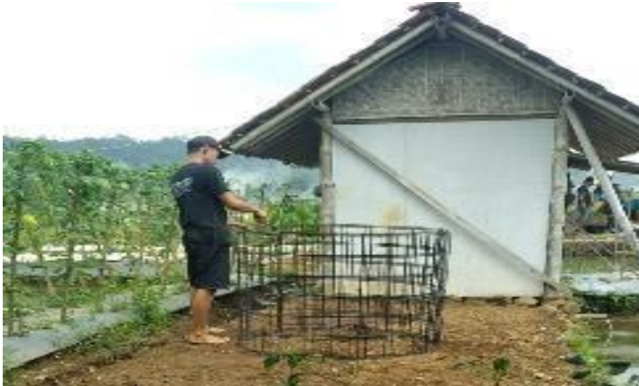
Gambar 4. Proses Pembuatan Kolam Terpal Bundar
