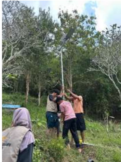
Gambar 3. Proses Pemasangan Tiang Lampu PJU Tenaga Surya oleh Tim KKN Unsoed Bersama Warga Desa Semampir
