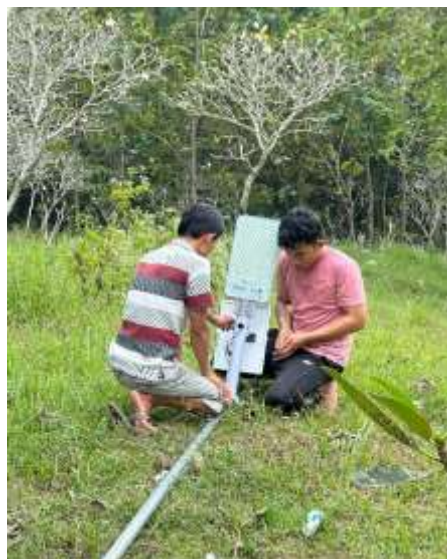
Gambar 2. Tahap Perakitan Komponen Panel Surya dan Lampu
